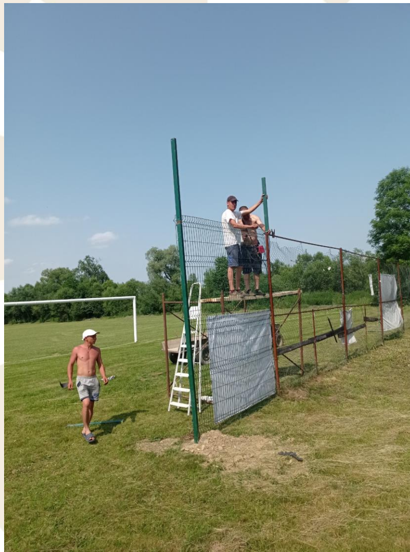
Монтаж захисних сіток
